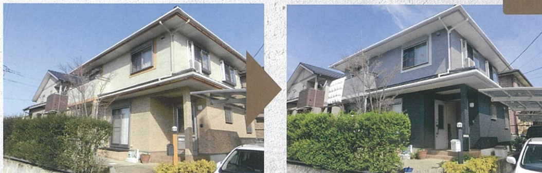
【外壁塗装】ハイブリッド系フッ素塗料 ベージュ系をグレー系の2色使いに塗替え、モダンな風合いの外観に変わりました。
